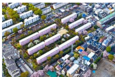
「従前建物外観」
