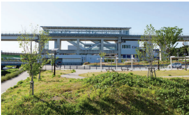
地下調整池の上部を利用した広場
