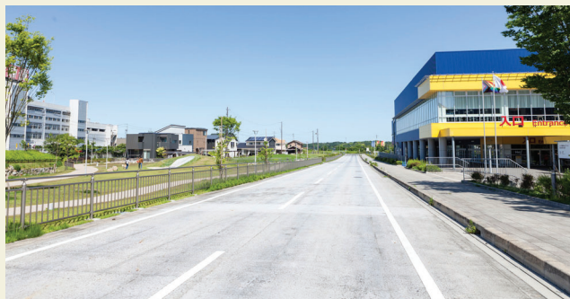
車道の遮熱性舗装と歩道の遮熱保水性舗装
